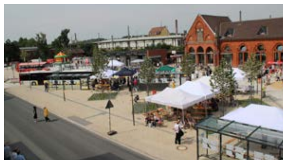
Plein voor het station, met de nieuwe betonnen bestrating en weg
